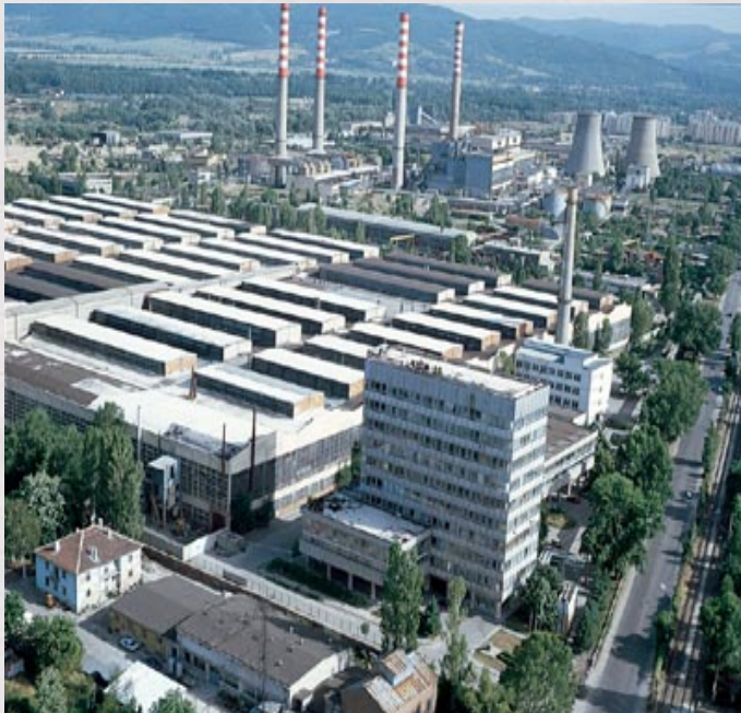
SOFIA MED Plant
