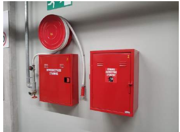
Πυροσβεστικός Σταθμός και Φωλιά
