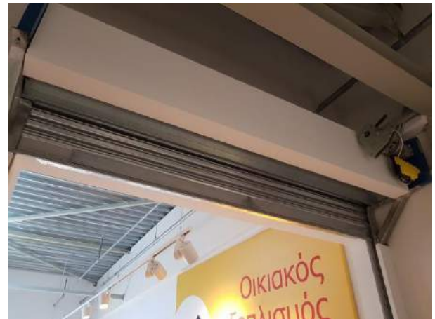
Αυτόματο ρολό πυροπροστασίας
