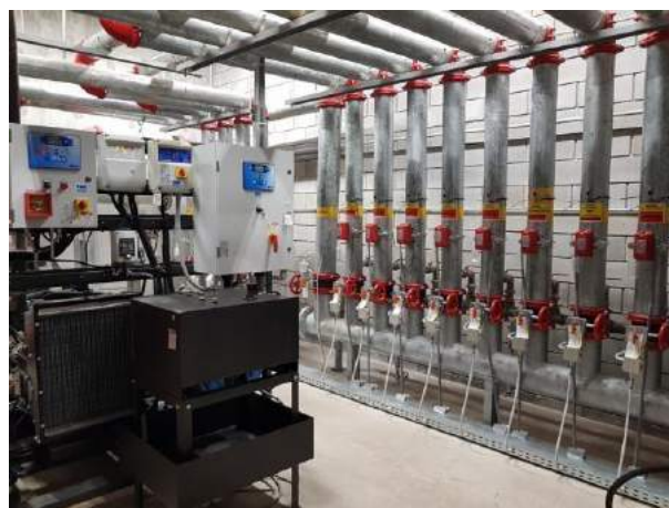
Πυροσβεστικό συγκρότημα και βάνες διανομής
