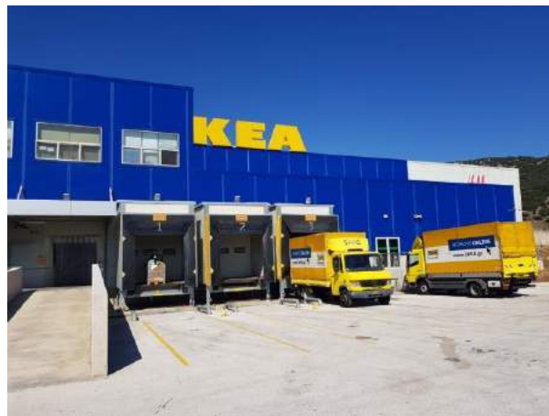
Ράμπες τροφοδοσίας (ισόγειο, πίσω πλευρά)
