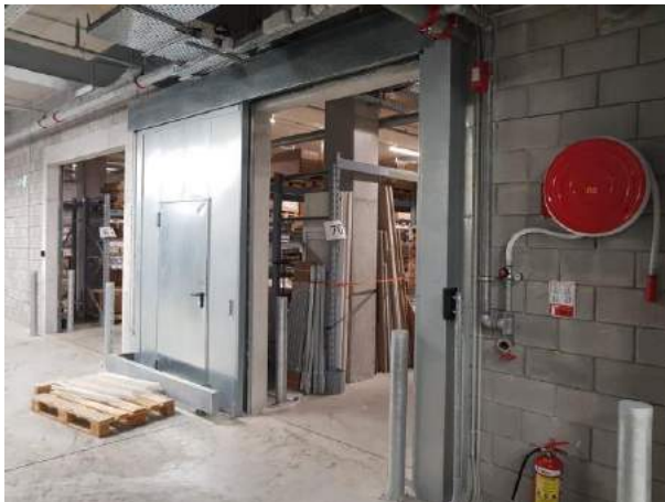
Αυτόματη θύρα πυροπροστασίας
