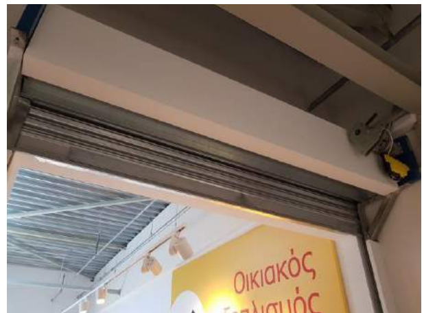
Αυτόματο ρολό στο αίθριο του κλιμακοστασίου
