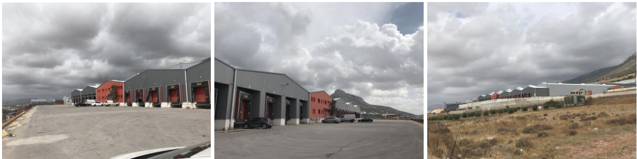
Ενδεικτικές Φωτογραφίες Κτιρίου Κ1, Ακινήτου Α – Κύριλλος (Πηγή: Αυτοψία 18/09/2020)
