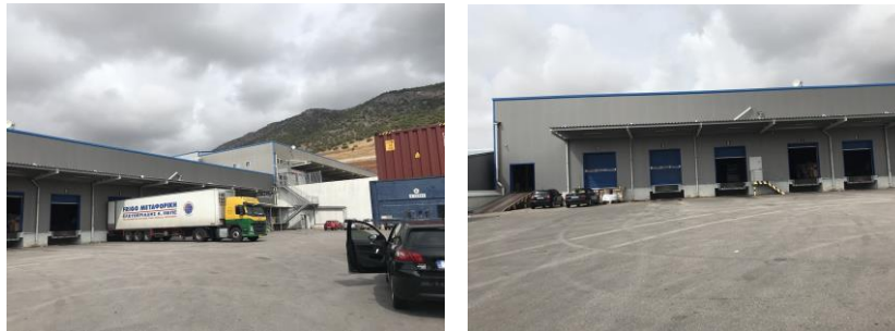
Ενδεικτικές Φωτογραφίες Κτιρίου Κ2, Ακινήτου Α – Κύριλλος (Πηγή: Αυτοψία 18/09/2020)
