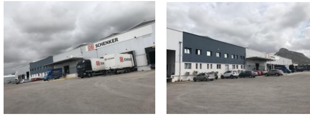
Ενδεικτικές Φωτογραφίες Κτιρίου Κ4, Ακινήτου Α – Κύριλλος (Πηγή: Αυτοψία 18/09/2020)
