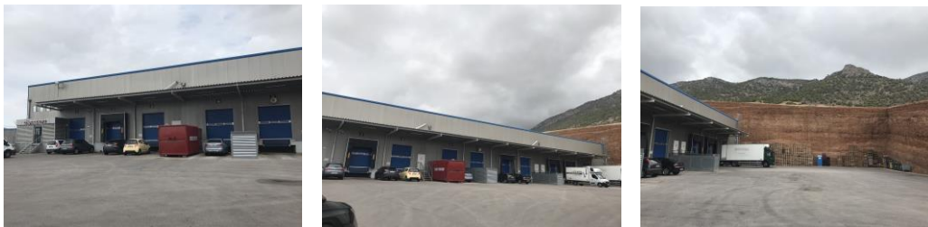
Ενδεικτικές Φωτογραφίες Κτιρίου Κ3, Ακινήτου Α – Κύριλλος (Πηγή: Αυτοψία 18/09/2020)
