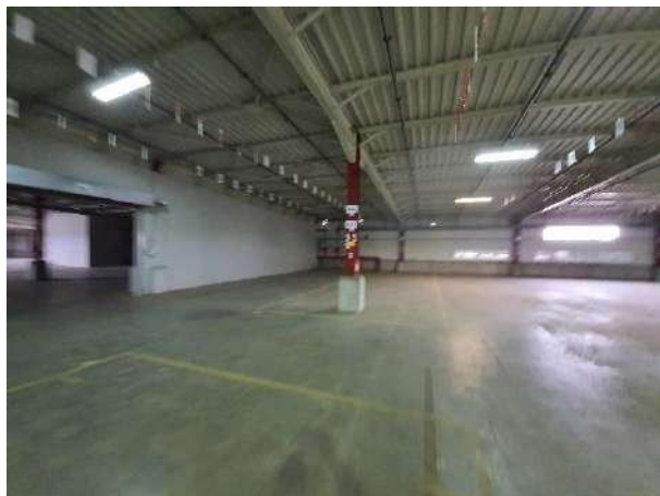
1ος όροφος κτίριο Α
