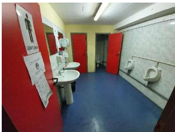
WC γραφειακών χώρων κτίριο Α
