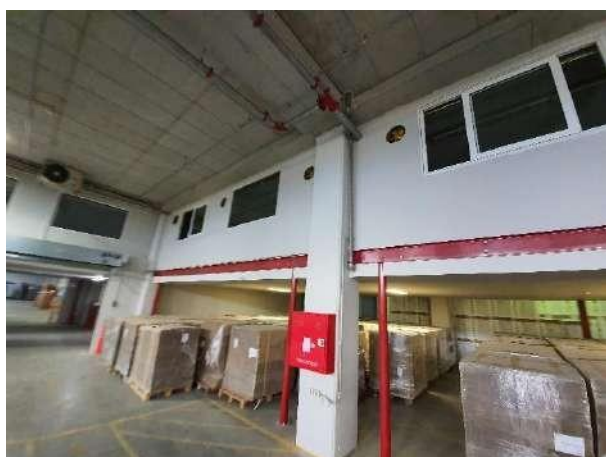
Γραφειακοί χώροι κτίριο Α
