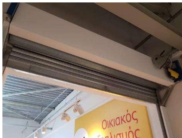
Αυτόματο ρολό πυροπροστασίας
