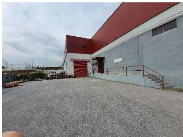
Εξωτερική άποψη κτιρίου Α
