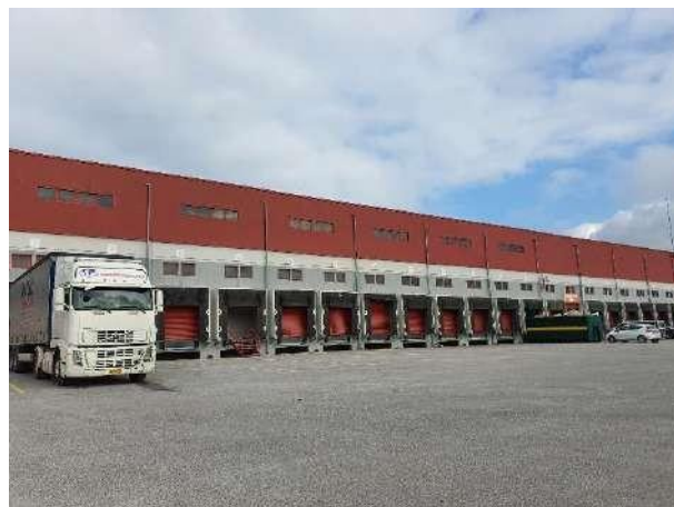
Εξωτερική άποψη κτιρίου Α
