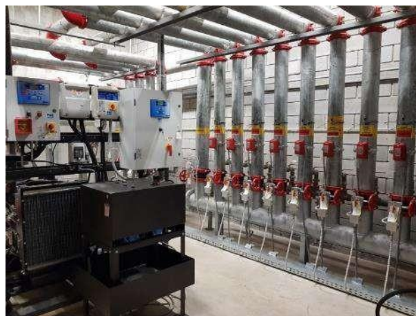
Πυροσβεστικό συγκρότημα και βάνες διανομής
