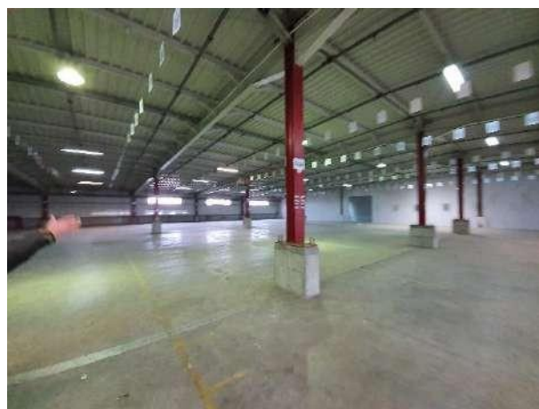
1 ος όροφος κτίριο Α
