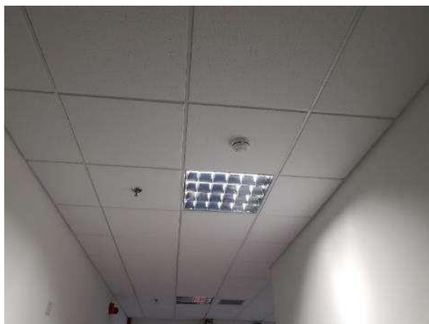
Λεπτομέρεια ψευδοροφής γραφείων
