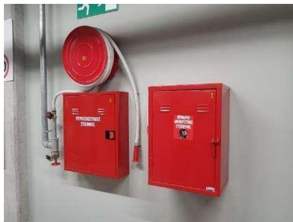
Πυροσβεστικός Σταθμός και Φωλιά
