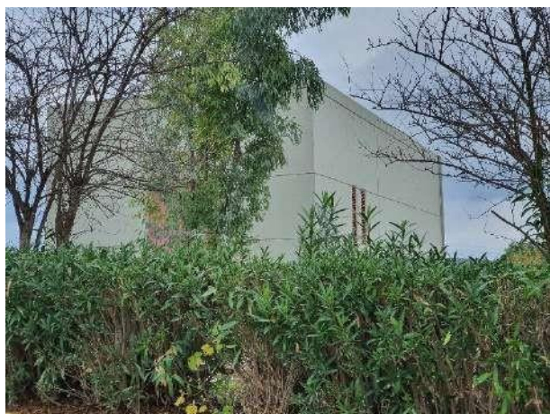
Κτίριο στέγασης δεξαμενής
