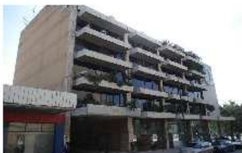
Εμπρός, επί της Λαγουμιτζή, όψη. Αριστερά τα υπό κατεδάφιση παλαιά κτίρια στο όμορο οικόπεδο. Δεξιά η Λ. Συγγρού.
