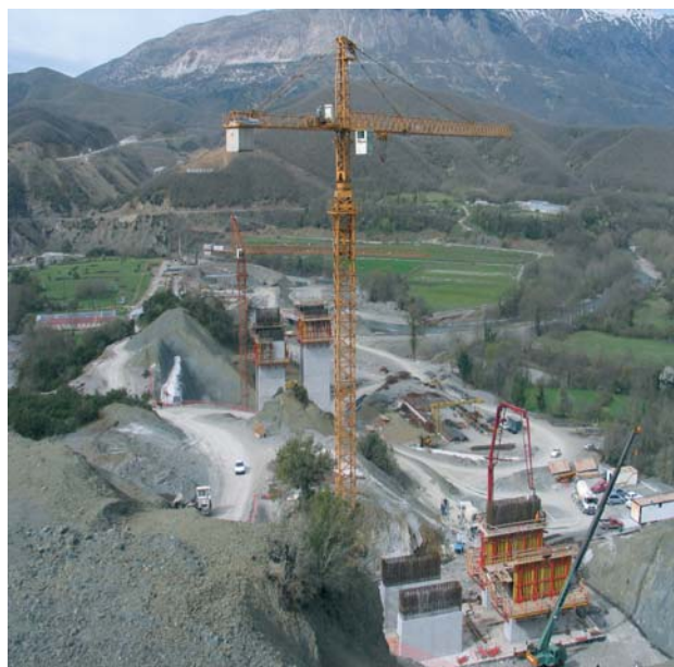
ΓΕΦΥΡΑ ΑΡΑΧΘΟΥ - ΙΩΑΝΝΙΝΑ
