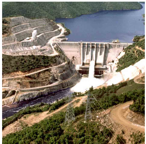
ΦΡΑΓΜΑ ΠΛΑΤΑΝΟΒΡΥΣΗΣ - ΝΕΣΤΟΣ
