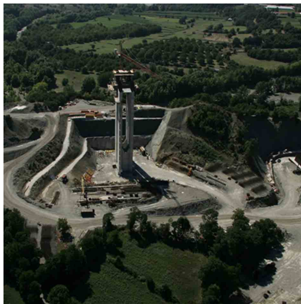
ΓΕΦΥΡΑ ΑΡΑΧΘΟΥ - ΙΩΑΝΝΙΝΑ
