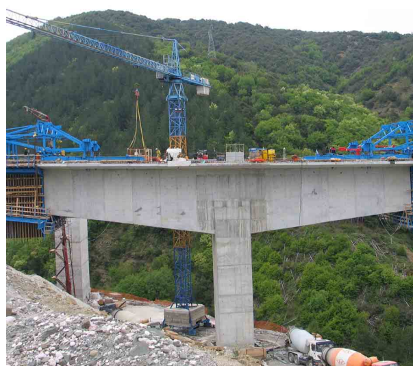
ΓΕΦΥΡΑ ΑΡΑΧΘΟΥ - ΙΩΑΝΝΙΝΑ
