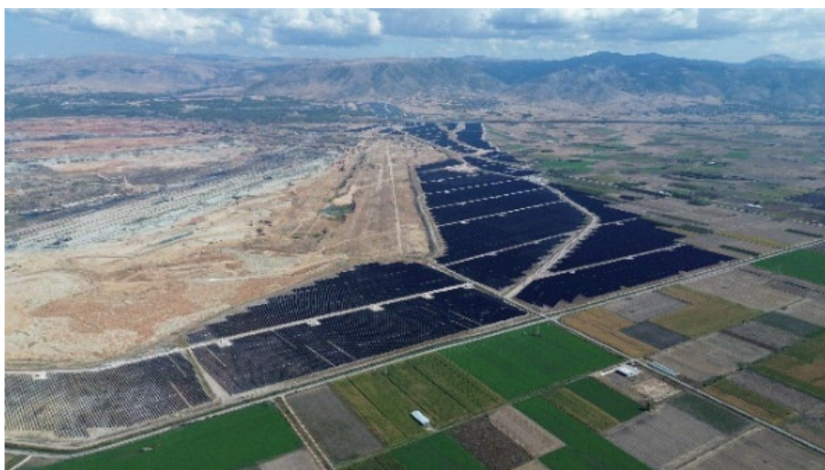
Εικόνα 1: Τμήμα φωτοβολταϊκού σταθμού ισχύος 550 MW πλησίον του ΑΗΣ Αγίου Δημητρίου.
