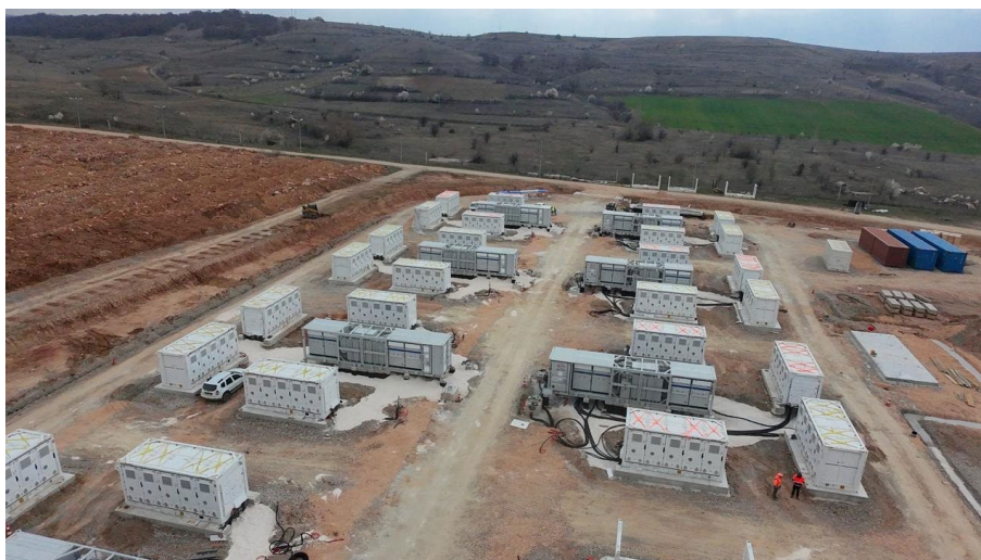
Εικόνα 3: Συστοιχία συσσωρευτών του Σταθμού Ηλεκτροχημικής Αποθήκευσης Μελίτης Ι.
